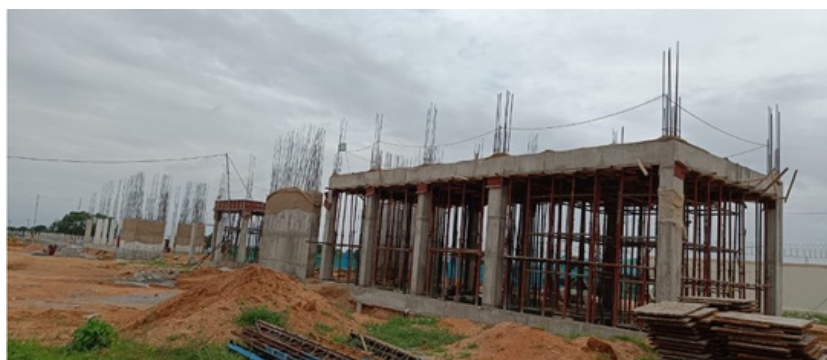
Slab work at 4.5 meters level under progress 4.5 मीटर स्तर पर स्लैब का कार्य जारी है।
